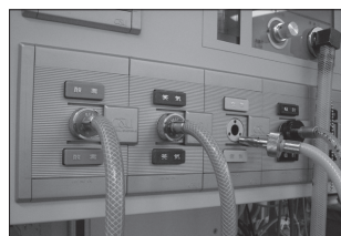
(1 番右は吸引の配管) 図 4.9 酸素、笑気、空気の配管
